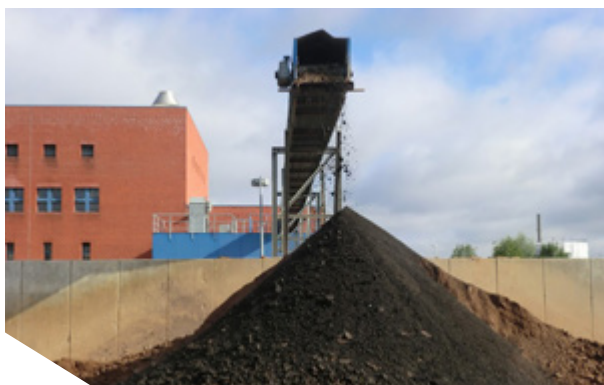
Рис. 6-4: Обработанный известковым молоком и обезвоженный осадок. Фото: Entsorgungsbetriebe Lübeck
