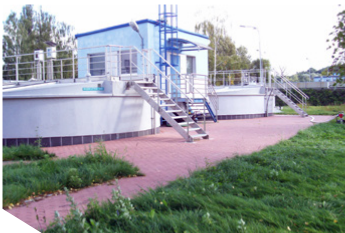
Рис. 3-4: Гравитационные илоуплотнители на ОСК «Здрое» в Щецине (Польша). Фото: ZWIK Szczecin
