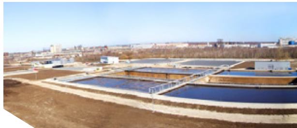
Рис. 6-7: Очистные сооружения в Кохтла-Ярве. Фото: OÜ Järve Biopuhastus
