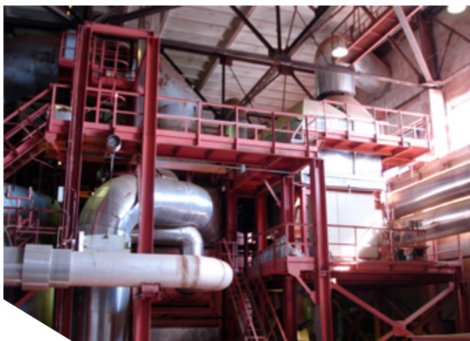
Рис. 8-2: Установка по сжиганию осадка в Санкт-Петербурге. Фото: Лотта Руоканен
