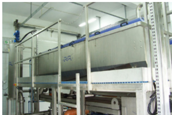
Рис. 3-5: Барабанный илоуплотнитель в Юрмале (Латвия) и Щецине (Польша). Фото: PIU Jūrmalas ūdens и ZWiK Szczecin
