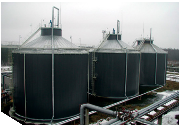
Рис. 4-2: Различные формы метантенков в Любеке (Германия) и Риге (Латвия). Фото: Entsorgungsbetriebe Lübeck и SIA Rīgas ūdens
