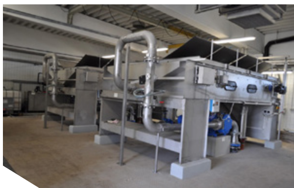
Рис. 3-6: Ленточный илоуплотнитель в Щецине (Польша) и Любеке (Германия). Фото: ZWIK Szczecin и Entsorgungsbetriebe Lübeck
