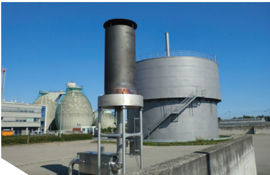
Рис. 4-6: Газовый факел, газгольдер и метантенки в Любеке (Германия). Фото: Entsorgungsbetriebe Lübeck
