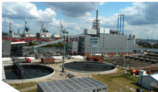
Рис. 8-1: Завод по моносжиганию осадка сточных вод VERA в г. Гамбурге. Фото: Vera Klärschlammverbrennung GmbH
