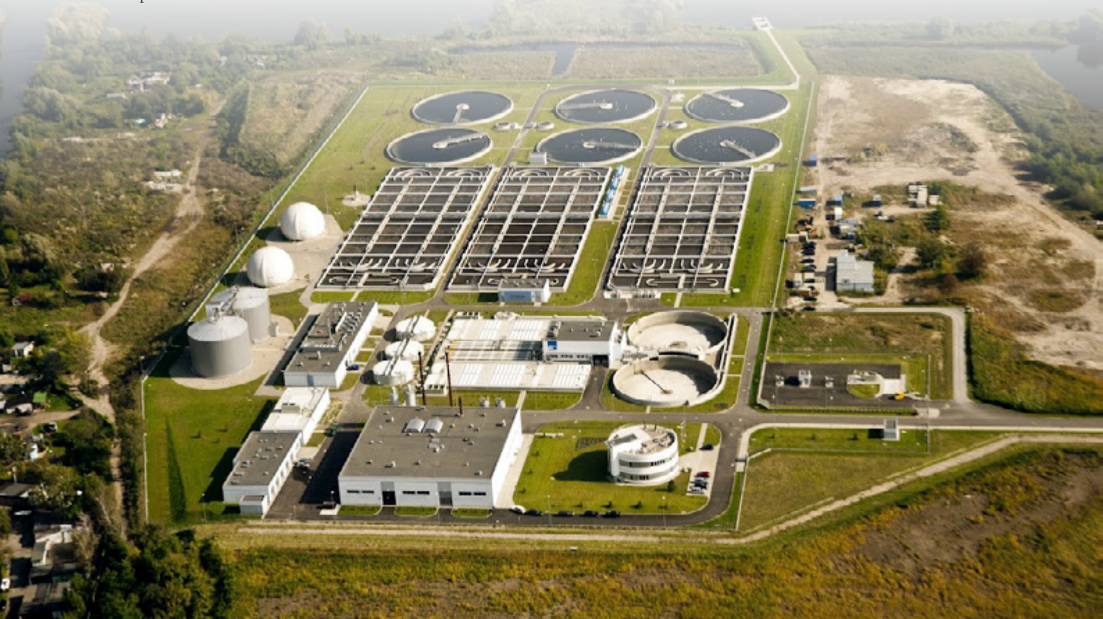
Рис. 7-5: Очистные сооружения «Поможаны», Щецин. Фото: ZWiK Szczecin
