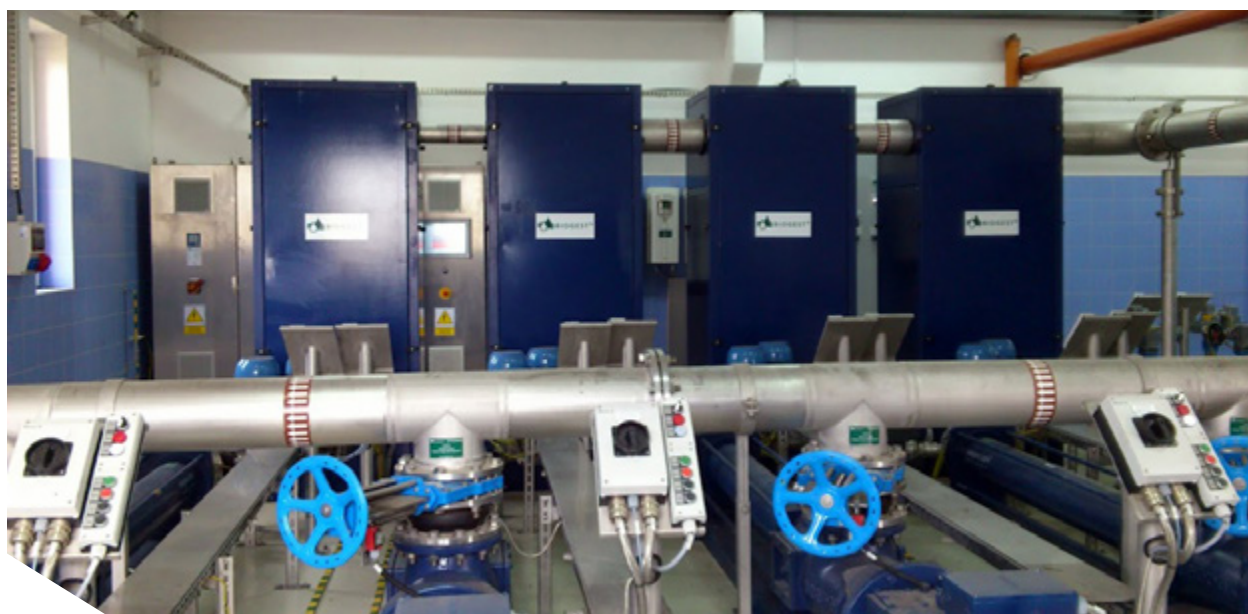
Рис. 4-3: Ультразвуковая дезинтеграция осадка сточных вод в Гданьске (Польша). Фото: GiWK
