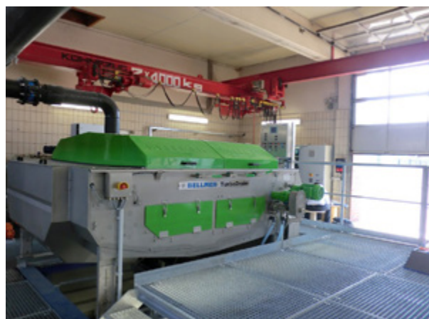
Рис. 3-6: Ленточный илоуплотнитель в Щецине (Польша) и Любеке (Германия). Фото: ZWIK Szczecin и Entsorgungsbetriebe Lübeck
