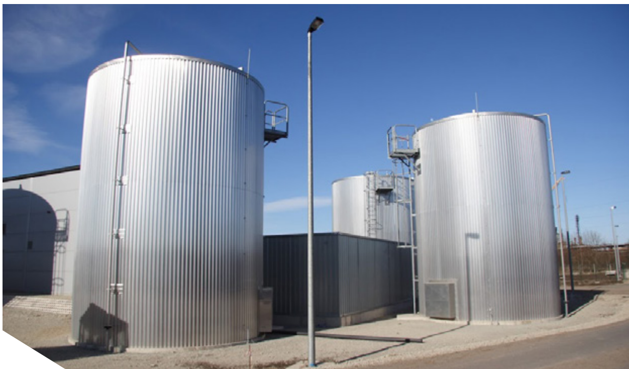
Рис. 6-2: Установка для пастеризации осадка в Кохтла-Ярве (Эстония). Фото: OÜ Järve Biopuhastus
