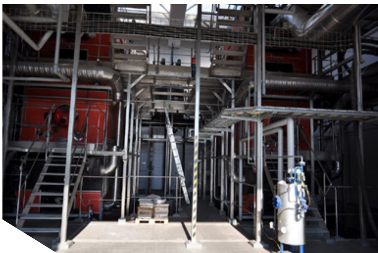
Рис. 7-3: Сушка и сжигание осадка в Щецине (Польша). Фото: ZWIK Szczecin
