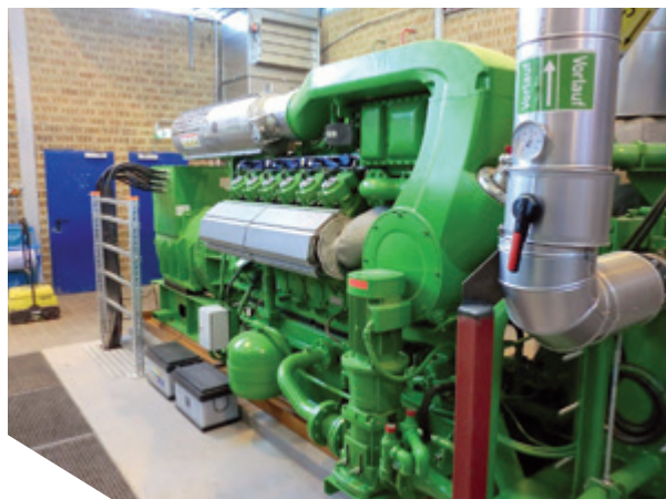
Ilustracja 4-8: Gazogeneratory w Szczecinie (Polska) i Lubece (Niemcy). Zdjęcia: ZWiK Szczecin i Entsorgungsbetriebe Lübeck.
