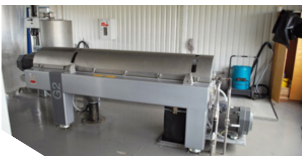
Ilustracja 5-3: Wirówki dekantacyjne w Jurmali i Rydze (Łotwa). Zdjęcia: SIA Rigas Udens i PIU Jūrmalas Udens.
