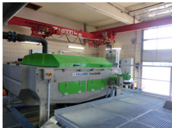
Ilustracja 3-6: Zagęszczacze taśmowe z Szczecina-Pomorzan y i Lubeki. Zdjęcia: ZWiK Szczecin i Entsorgungsbetriebe Lübeck.
