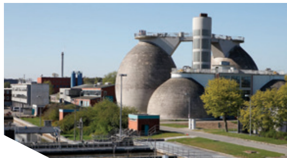
Ilustracja 4-10: Komory fermentacyjne w centralnej oczyszczalni ścieków w Lubece. Zdjęcie: Entsorgungsbetriebe Lübeck.
