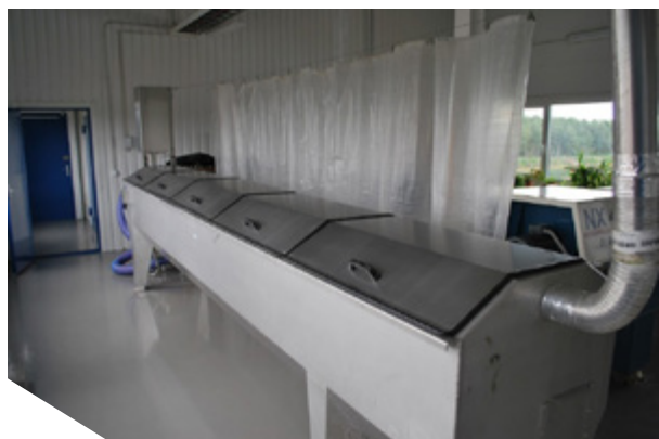
Ilustracja 3-5: Obrotowe zagęszczacze bębnowe w Jurmalu (Łotwa) i Szczecinie-Zdrojach (Polska) Zdjęcia: PIU Jurmalas Udens i ZWiK Szczecin.
