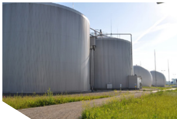
Ilustracja 7-4: Komory fermentacji osadu i zbiorniki gazu oczyszczalni ścieków Pomorzany w Szczecinie (Polska). Zdjęcie: ZWiK Szczecin.
