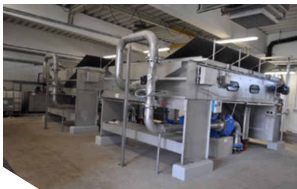
Ilustracja 3-6: Zagęszczacze taśmowe z Szczecina-Pomorzan y i Lubeki. Zdjęcia: ZWiK Szczecin i Entsorgungsbetriebe Lübeck.
