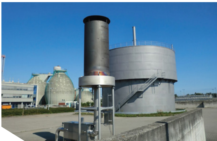
Ilustracja 4-6: Pochodnia gazowa, zbiornik gazu i komory fermentacyjne w Lubece w Niemczech. Zdjęcie: Entsorgungsbetriebe Lübeck.
