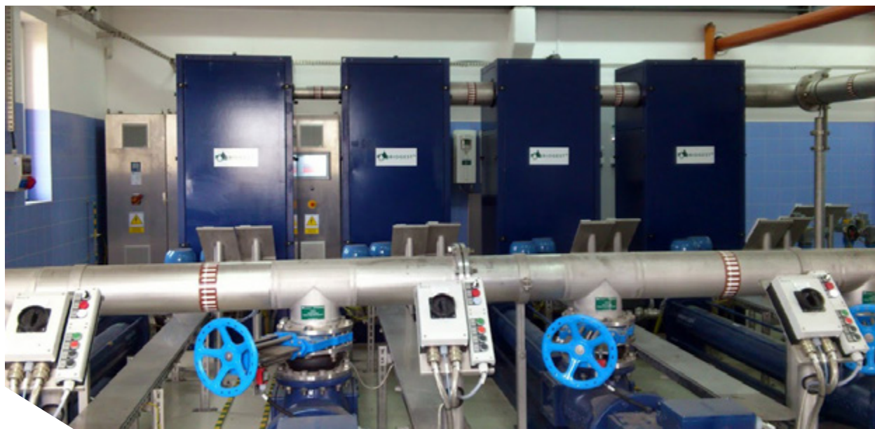
Ilustracja 4-3: Instalacja do dezintegracji ultradźwiękowej w Gdańsku (Polska). Zdjęcie: GIWK.
