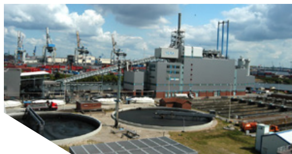
Ilustracja 8-1: Monospalarnia VERA w Hamburgu. Zdjęcie: VERA Klärschlammverbrennung GmbH.
