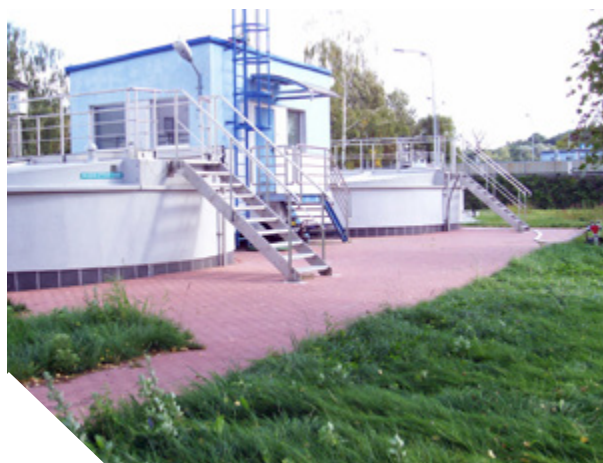
Ilustracja 3-4. Zagęszczacze grawitacyjne w oczyszczalni ścieków Zdroje, Szczecin, Polska Zdjęcie: ZWiK Szczecin.
