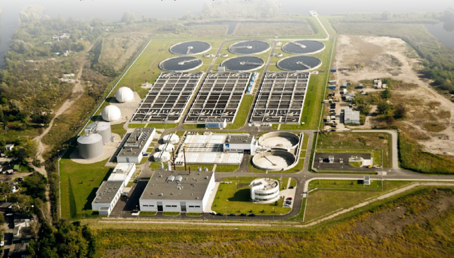
Ilustracja 7-5: Oczyszczalnia ścieków Pomorzany w Szczecinie. Zdjęcie: ZWiK Szczecin.
