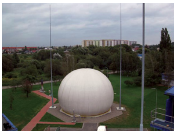
Ilustracja 4-7: Zbiorniki gazu w Rydze (Łotwa) i w Szczecinie (Polska). Zdjęcia: SIA Rigas Udens i ZWIK Szczecin.
