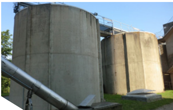
Ilustracja 3-2: Zagęszczacz grawitacyjny z Lubeki Zdjęcie: Entsorgungsbetriebe Lübeck.
