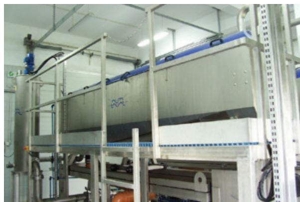
Ilustracja 3-5: Obrotowe zagęszczacze bębnowe w Jurmalu (Łotwa) i Szczecinie-Zdrojach (Polska) Zdjęcia: PIU Jurmalas Udens i ZWiK Szczecin.
