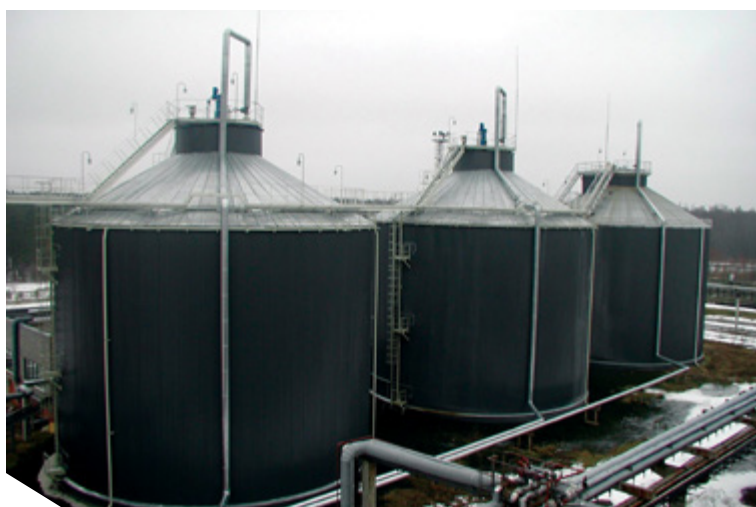
Ilustracja 4-2: Różne kształty komór fermentacji osadu w Lubece (Niemcy) i w Rydze (Łotwa) Zdjęcia: Entsorgungsbetriebe Lübeck i SIA Riga Udens.
