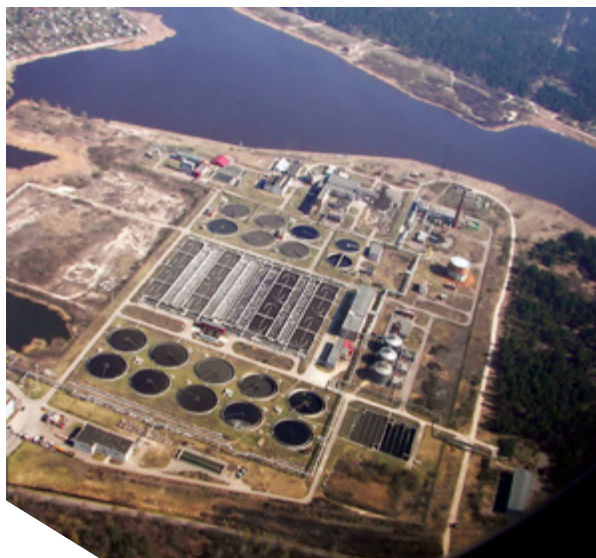
Ilustracja 3-7: Oczyszczalnia ścieków Daugavgrīva w Rydze. Zdjęcie: SIA Rigas Udens.
