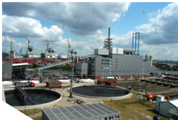
Abbildung 8-1: Monoverbrennungsanlage VERA in Hamburg. Foto: VERA Klärschlammverbrennung GmbH.
