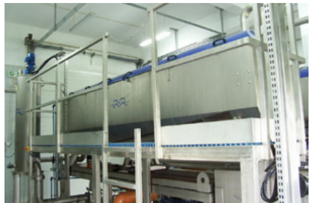
Abbildung 3-5: Drehbare Trommeleindicker in Jurmala, Lettland, und Stettin, Polen. Fotos: PIU Juralmas Udens und ZWiK Szczecin.
