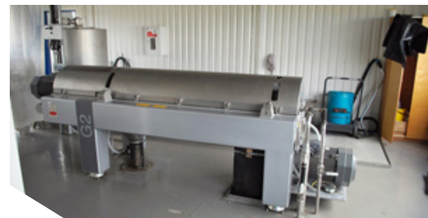
Abbildung 5-3: Dekanterzentrifugen in Riga und Jurmala, Lettland. Fotos: SIA Rigas Udens und PIU Jurmalas Udens.
