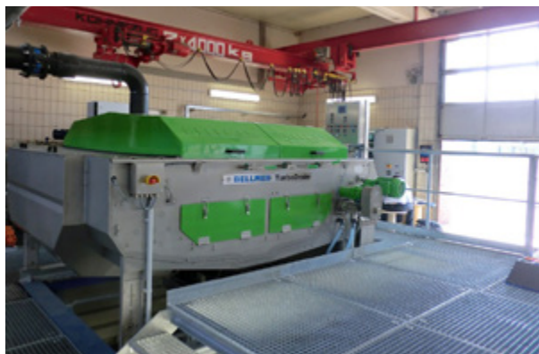
Abbildung 3-6: Bandeindicker in Lübeck und Stettin. Fotos: Entsorgungsbetriebe Lübeck und ZWiK Szczecin.
