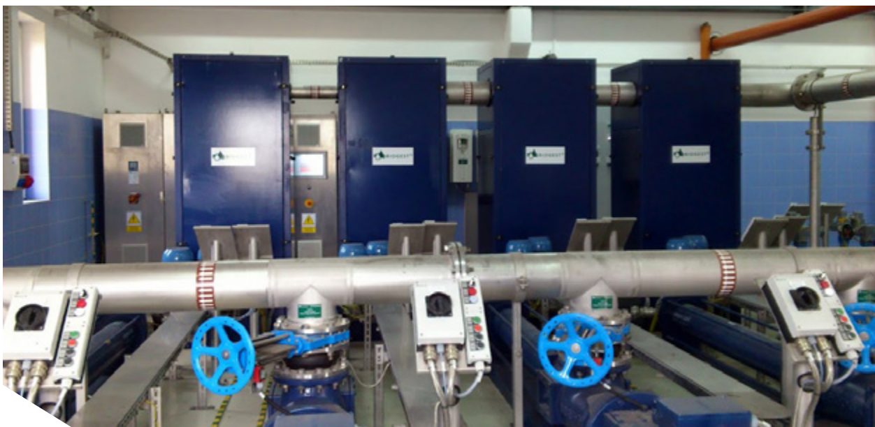
Abbildung 4-3: Ultraschall-desintegration in Danzig, Polen. Foto: GIWK.
