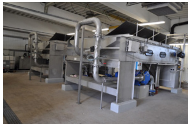
Abbildung 3-6: Bandeindicker in Lübeck und Stettin. Fotos: Entsorgungsbetriebe Lübeck und ZWiK Szczecin.
