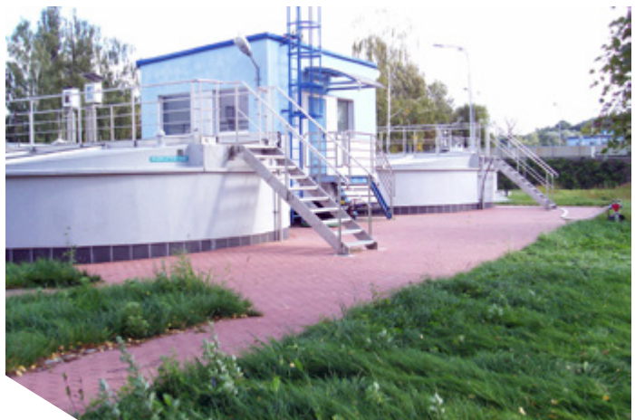
Abbildung 3-4: Statischer Eindicker in der Kläranlage Zdroje in Stettin, Polen. Foto: ZWiK Szczecin.
