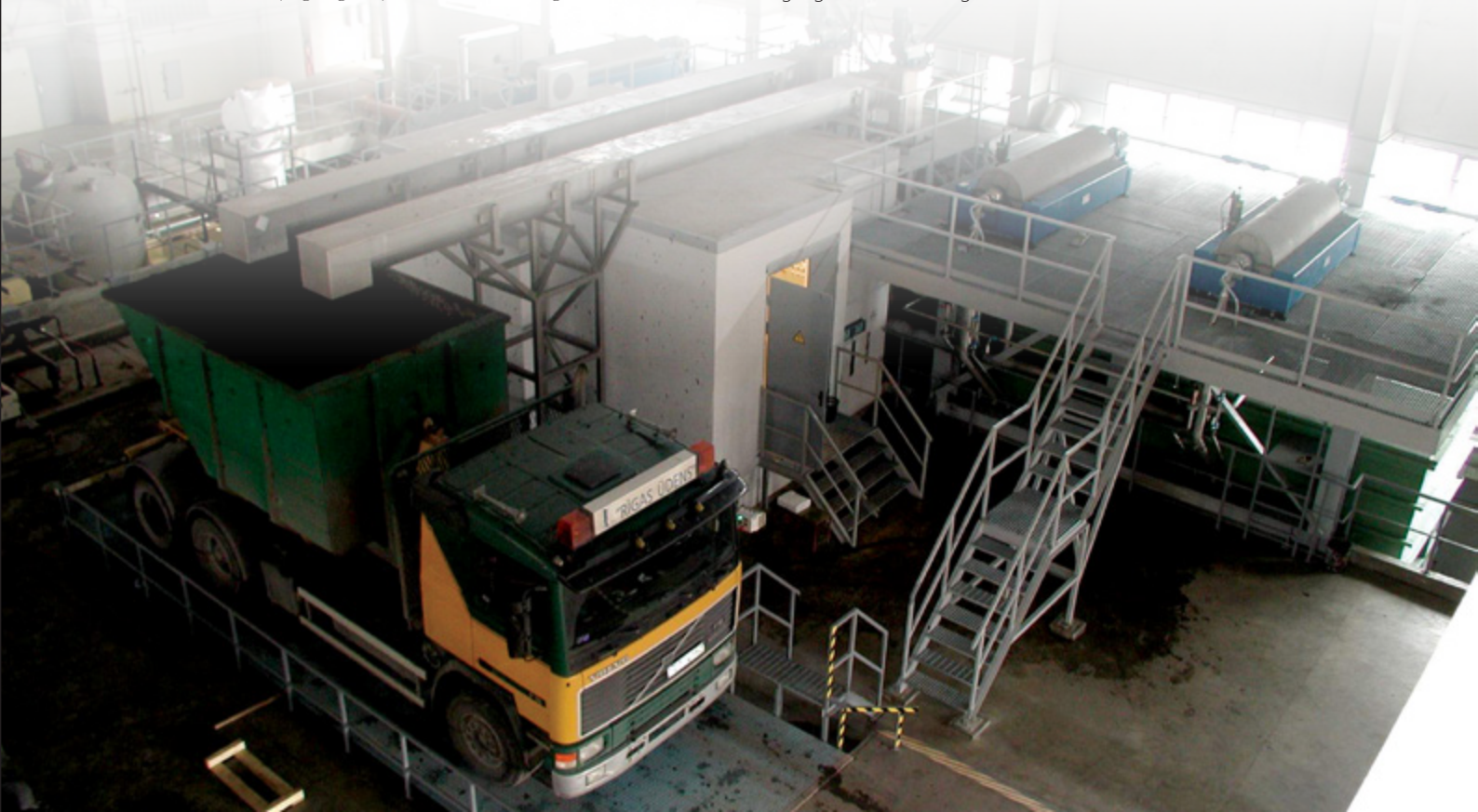
Abbildung 3-8: Schlammtransport in der Kläranlage Daugavgrīva. Foto: SIA Rigas Udens.
