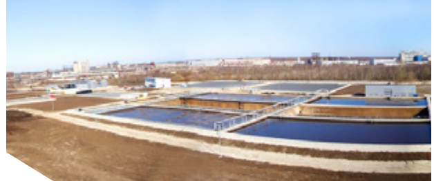
Abbildung 6-7: Kläranlage in Kohtla-Järve. Foto: OÜ Järve Biopuhastus.
