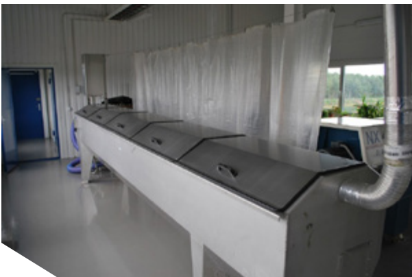
Abbildung 3-5: Drehbare Trommeleindicker in Jurmala, Lettland, und Stettin, Polen. Fotos: PIU Juralmas Udens und ZWiK Szczecin.
