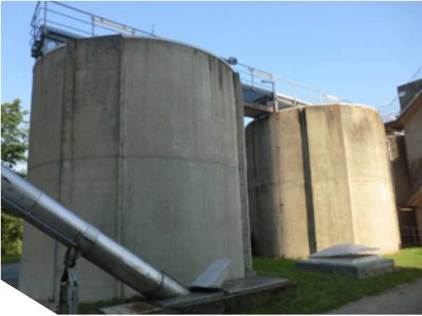
Abbildung 3-2: Statischer Eindicker in Lübeck. Foto: Entsorgungsbetriebe Lübeck.
